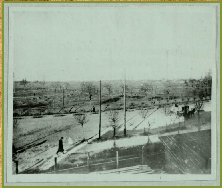
Начало работ по закладке парка имени Революции. г. Ростов-на-Дону. 1926 год
